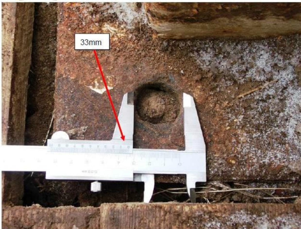
Kuva 5. Polttoleikkaamalla suurennettu reikä. Pulltipipituus oli liian lyhyt, joten mutterit ovat jääneet asentamatta. (kuva: poliisi)
