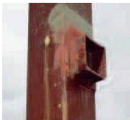
Pilareihin oli hitsattu pienahitsein vahvistuslevy ja vahvistuslevyyn konsoli. Konsolien tehtävä oli kannatella vaakapalkkeja, joiden varassa ontelolaatat olivat.
