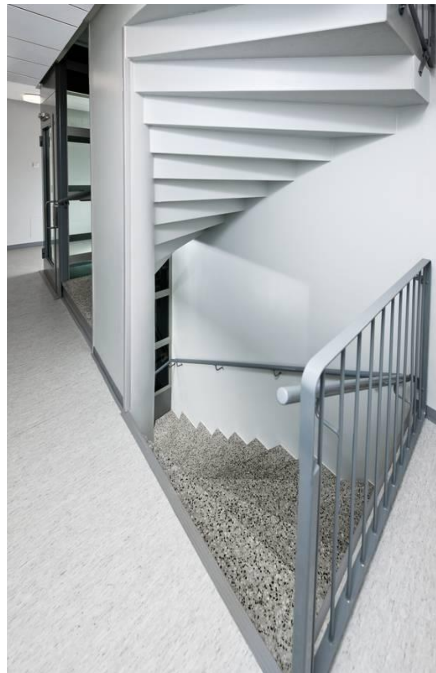
Hissikuilut, portaan, välipohjat
