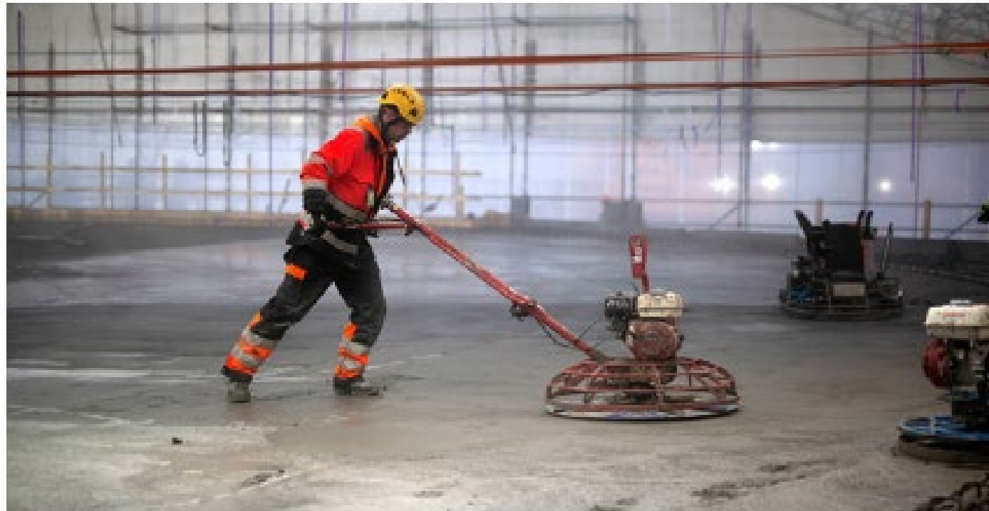
Kuva 3.17. Pinnan tiivistykseen ja lujittamiseen käytetään hiertokoneita (edessä käsin ohjattava ja taustalla päältä istuttava).
