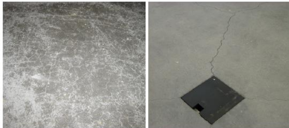
Kuva 4.1.3. Plastisesta kutistumasta (vasemmalla) ja kuivumiskutistumasta (oikealla) aiheutunutta betoninlattiaan halkeilua (kuvat Pentti Lumme).
