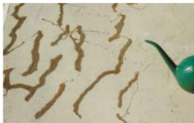
Kuva 4. Imeytysaine on kaadettu halkeaman päälle (vaihe 1).
