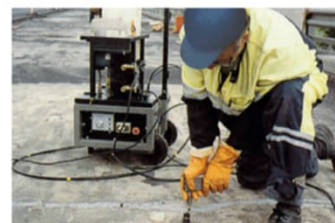
Kuva 1. Halkeaman injektointia muovilla.
