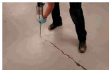
Kuva 8. Imeytys suuttimen avulla.
