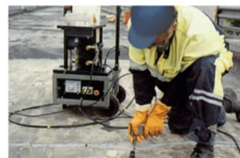
Kuva 1. Halkeaman injektointia muovilla.
