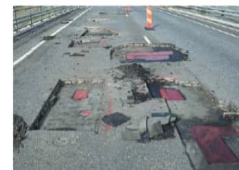
Kuva 1. Kivimievauriokehittämisen avare uudella sillalla
