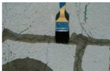
Kuva 5. Imeytysaine pidetään liikkeessä siveltimellä (vaihe 2).
