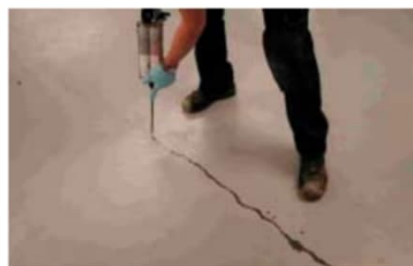
Kuva 8. Imeytys suuttimen avulla.
