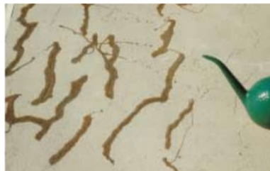
Kuva 4. Imeytysaine on kaadettu halkeaman päälle (vaihe 1).
