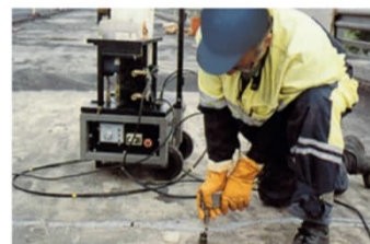
Kuva 1. Halkeaman injektointia muovilla.
