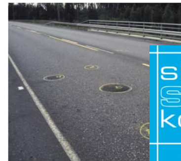
Kuva 1. Höyrystyneen kosteuden aihe kuplia päällysteessä.
