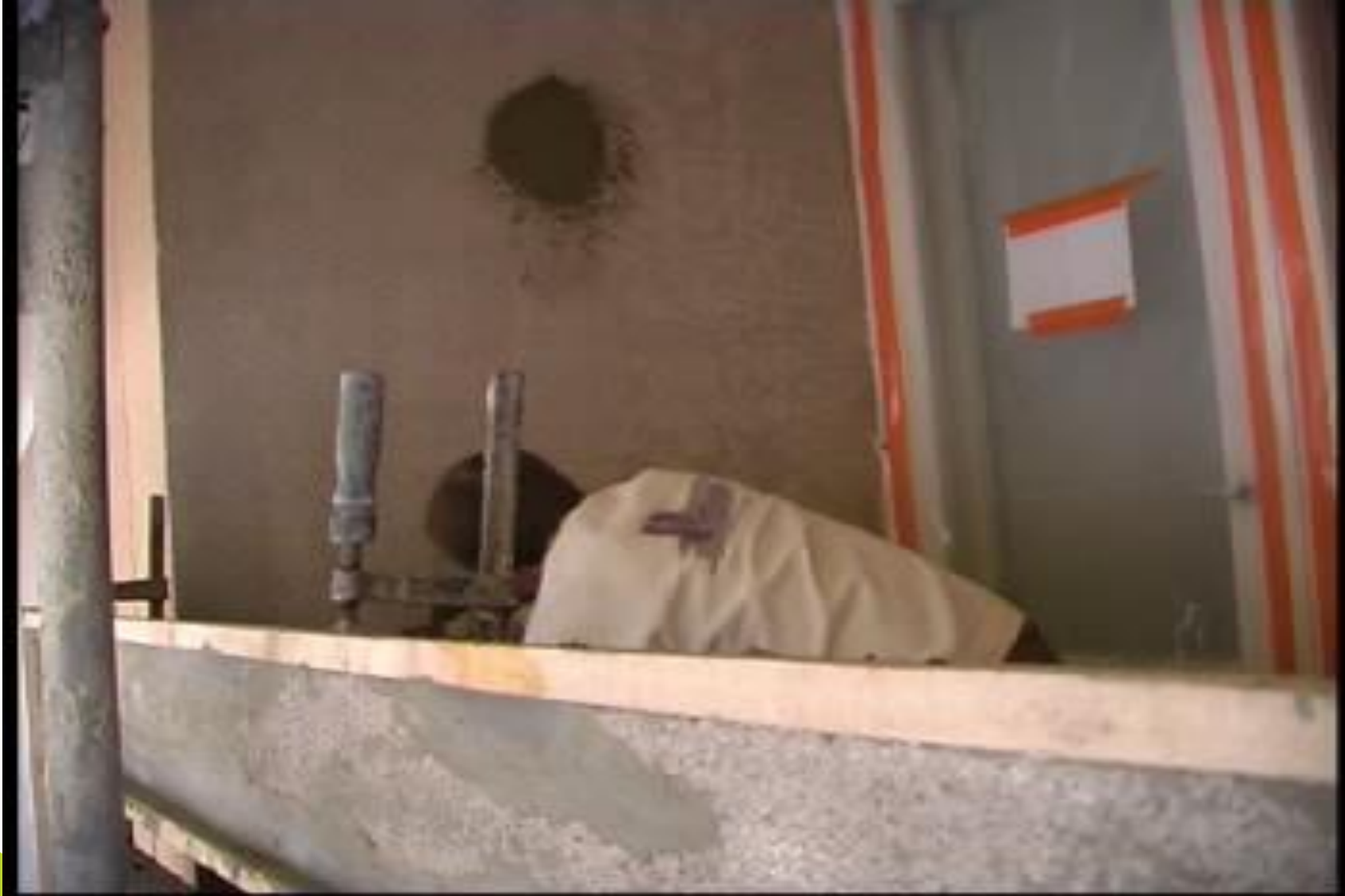
Betonirakenteiden korjaaminen. P. Silvennoinen, Consti Korjausrakentaminen Oy
