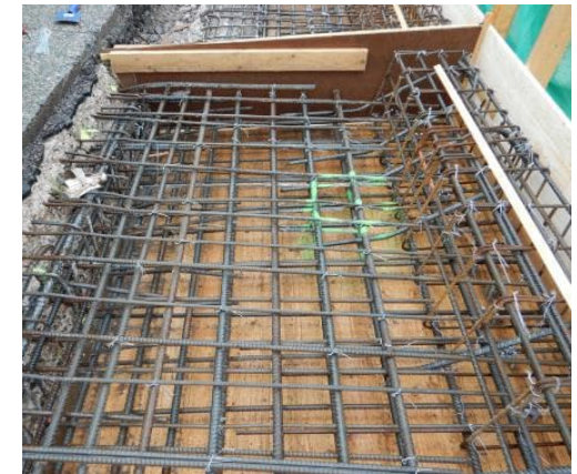
Sillalaatan leventäminen jälkivalukaistan avulla.
