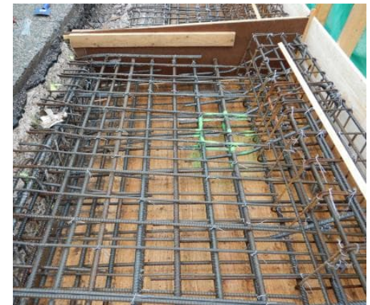
Siltalaatan leventäminen jälkivalukaistan avulla.
