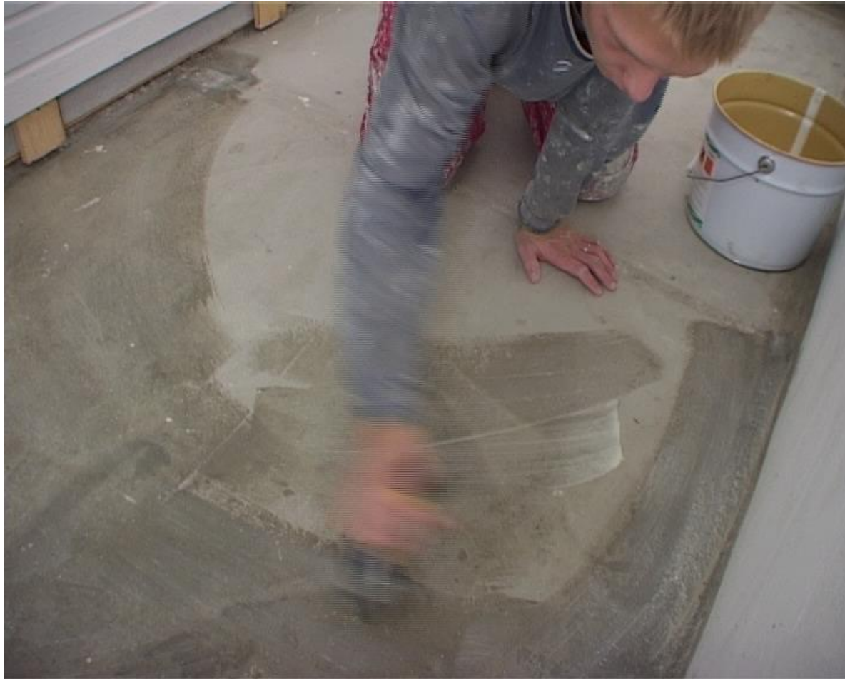
Betonirakenteiden korjaaminen, Petri Silvennoinen, Consti Korjausrakentaminen Oy
