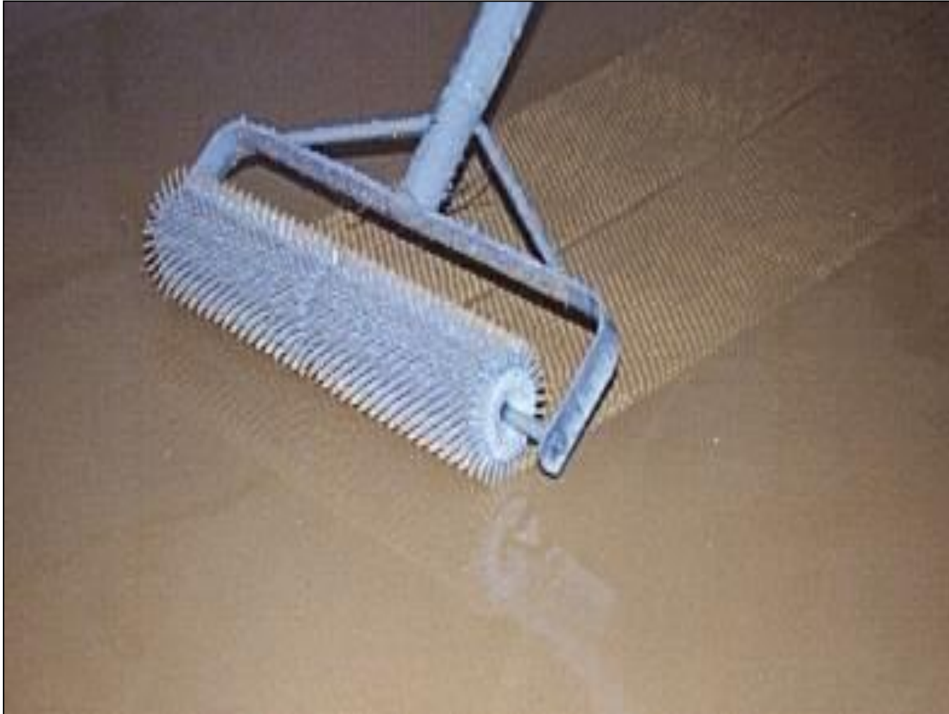
Betonirakenteiden korjaaminen, Petri Silvennoinen, Consti Korjausrakentaminen Oy
