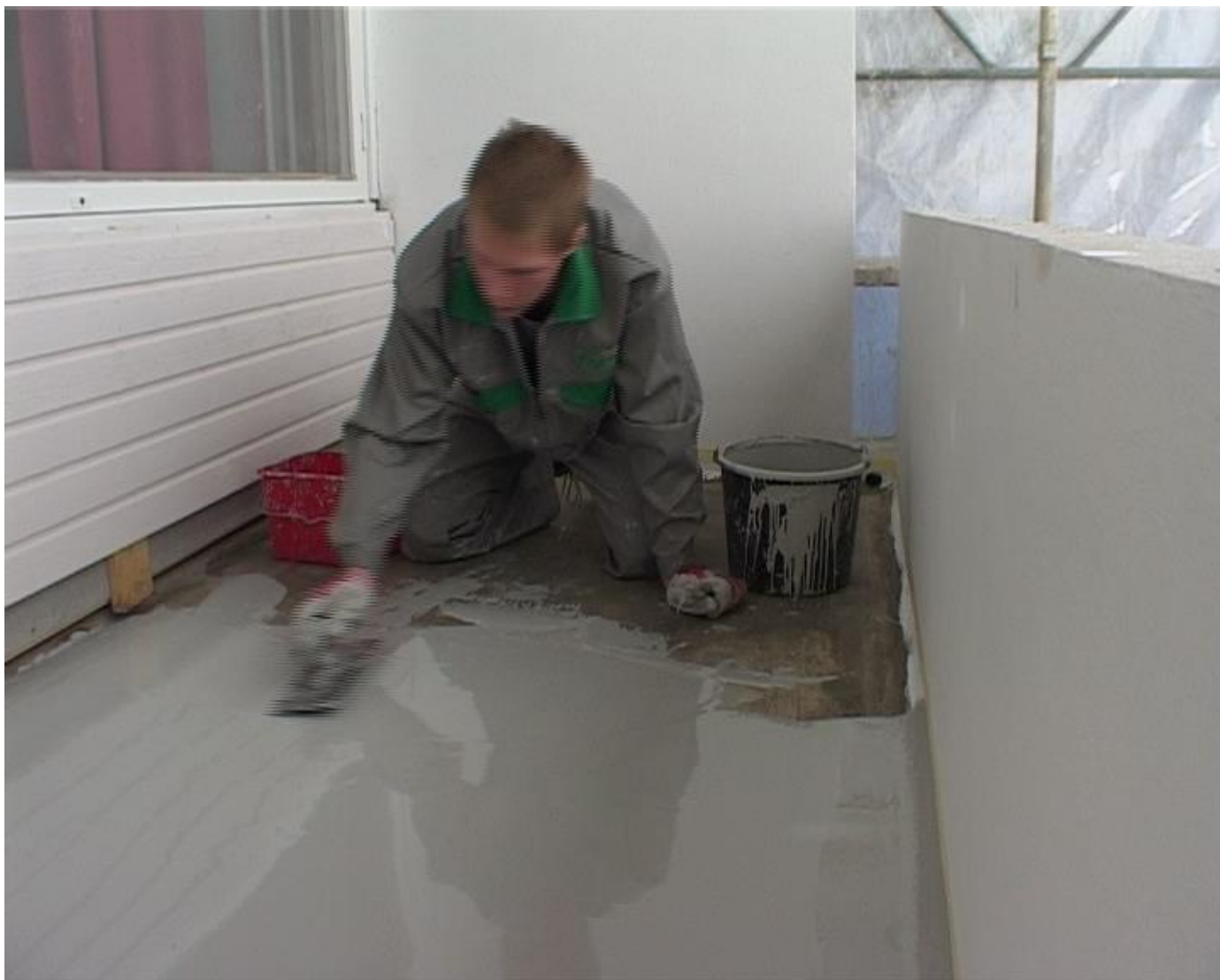
Betonirakenteiden korjaaminen, Petri Silvennoinen, Consti Korjausrakentaminen Oy
