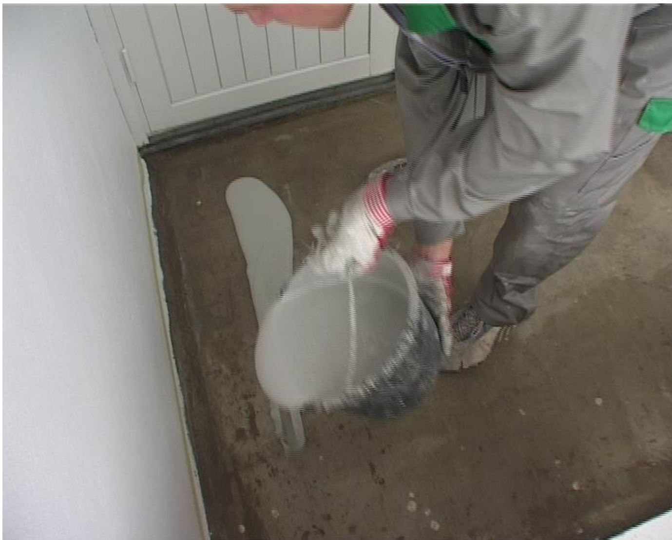
Betonirakenteiden korjaaminen, Petri Silvennoinen, Consti Korjausrakentaminen Oy
