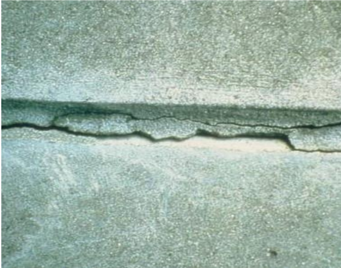
Betonirakenteiden korjaaminen, Petri Silvennoinen, Consti Korjausrakentaminen Oy
