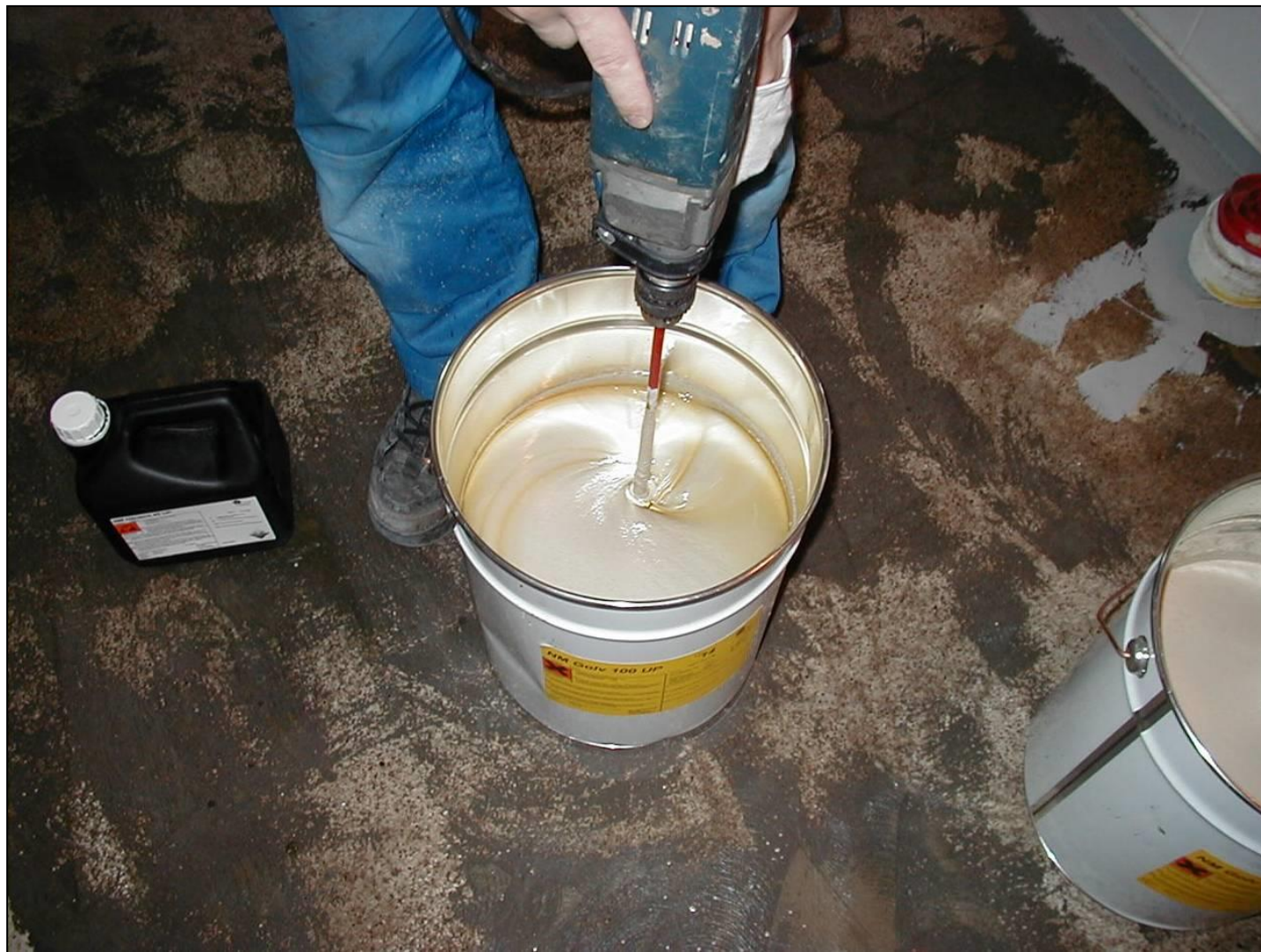
Betonirakenteiden korjaaminen, Petri Silvennoinen, Consti Korjausrakentaminen Oy
