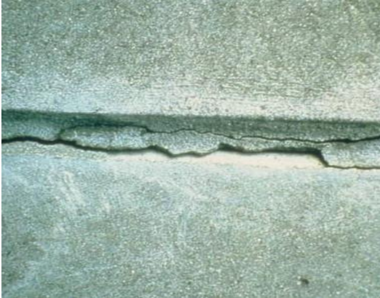
Betonirakenteiden korjaaminen, Petri Silvennoinen, Consti Korjausrakentaminen Oy
