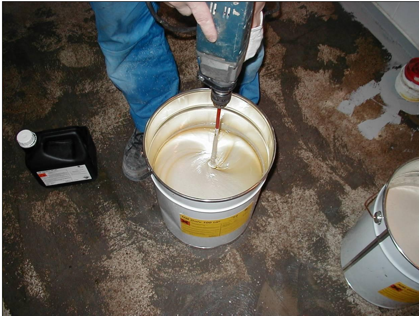
Betonirakenteiden korjaaminen, Petri Silvennoinen, Consti Korjausrakentaminen Oy
