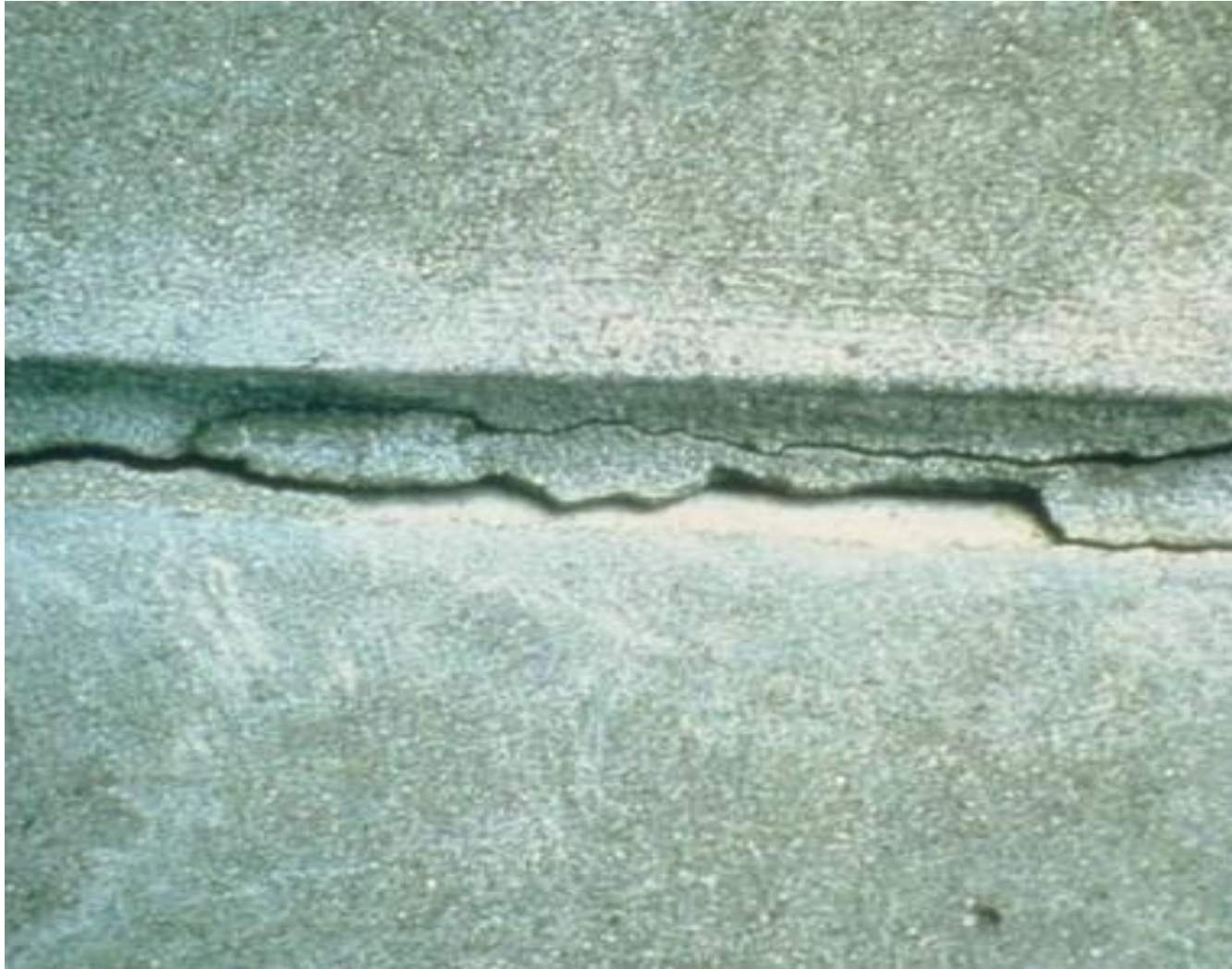
Betonirakenteiden korjaaminen, Petri Silvennoinen, Consti Korjausrakentaminen Oy
