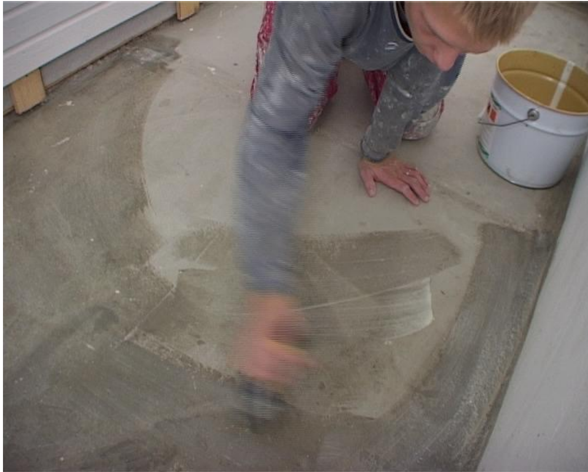
Betonirakenteiden korjaaminen, Petri Silvennoinen, Consti Korjausrakentaminen Oy
