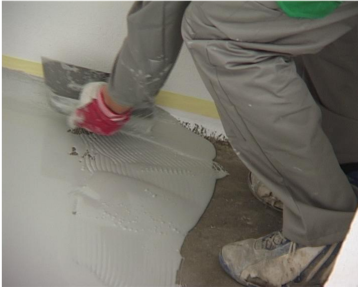
Betonirakenteiden korjaaminen, Petri Silvennoinen, Consti Korjausrakentaminen Oy
