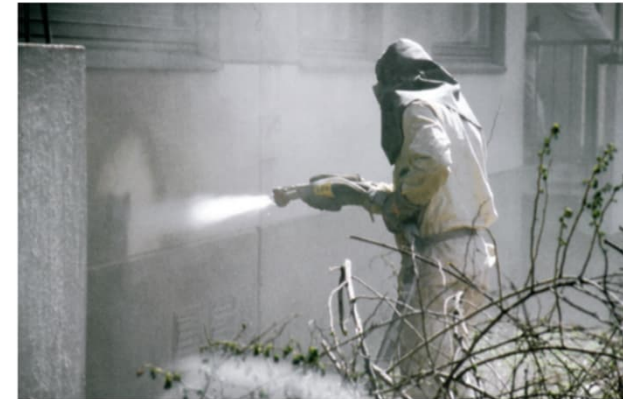
Kuva 7. Pinnan suihkupuhdistusta vesihiekkapuhalluksella. SILKO 2.253
