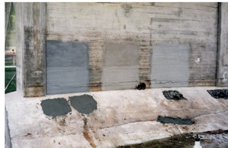
Betonirakenteiden korjaaminen 2024 - Korjaustyön valmist Kuva 9. Mallityö.
