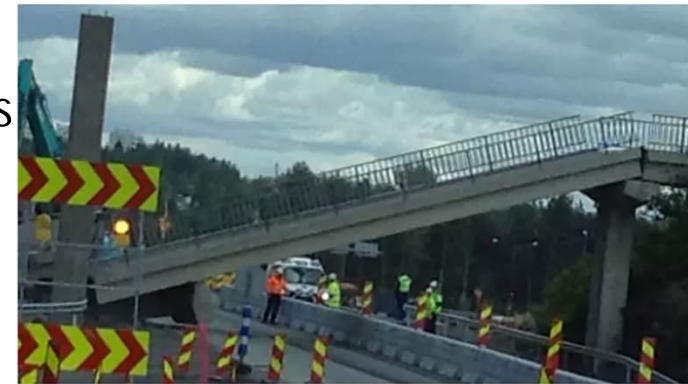
Kevenliikenteen silta romahti yllättäen Mikkelissä – katso kuva
