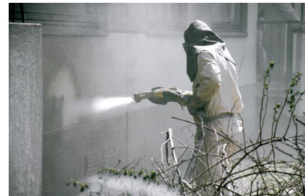
Kuva 7. Pinnan suihkupuhdistusta vesihiekkapuhalluksella. SILKO 2.253
