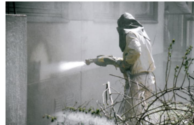
Kuva 7. Pinnan suihkupuhdistusta vesihiekkapuhalluksella. SILKO 2.253
