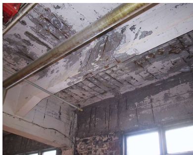
Teollisuushallin katto ennen
