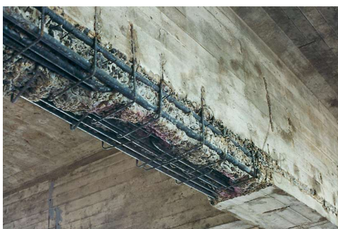
Palkki piikkauksen jälkeen...
