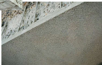
palkki alapinnan ruiskutuksen jälkeen...
