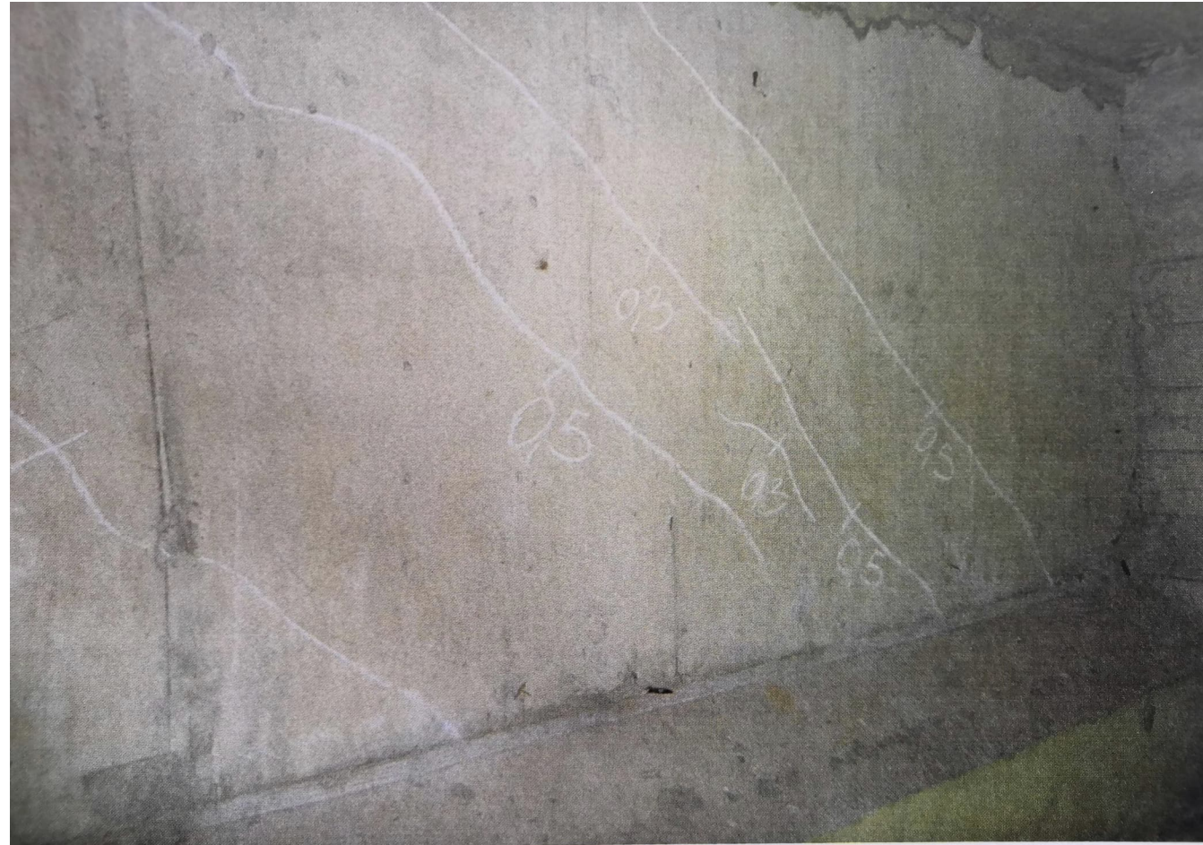
Kuva 26. Uuden osan palkin nro 4 leikkaushalkeamia.
