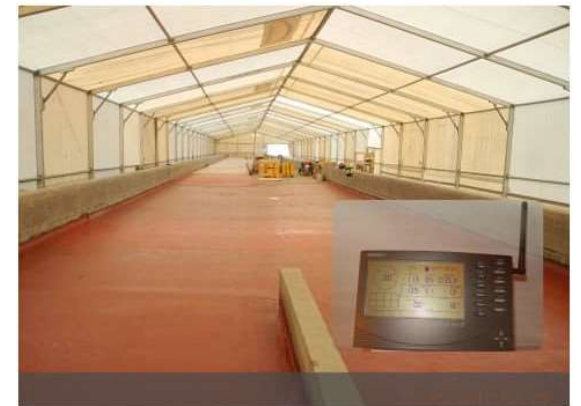
Sillan vedeneristystyömaan laadunmittaus 2017
