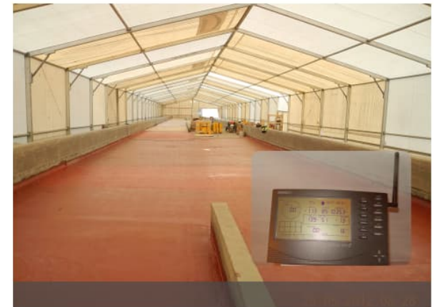
Sillan vedeneristystyömaan laadunmittaus 2017
