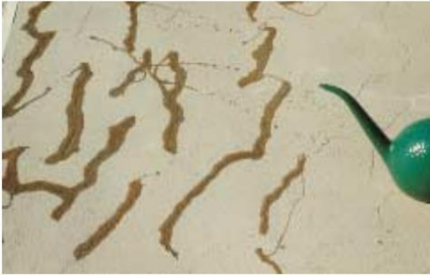
Kuva 4. Imeytysaine on kaadettu halkeaman päälle (vaihe 1).
