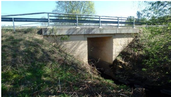
Orijärvenpuron silta, kannen pinta-ala 19 m 2 .
