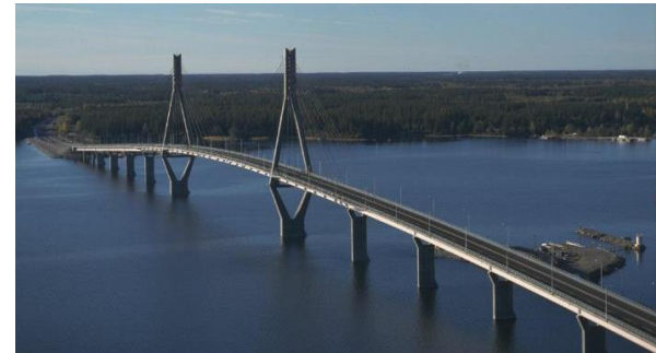
Raippaluodon silta, kannen pinta-ala 13 216 m 2 .
