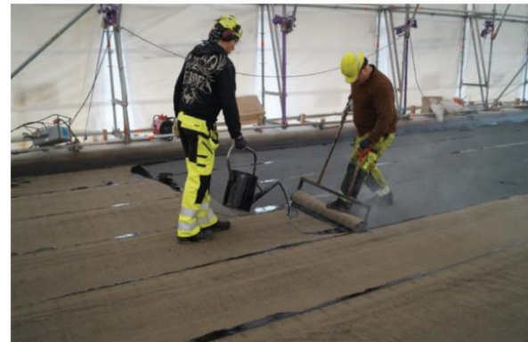
Kuva 1. Kermieristysten tekoa liimaamalla.
