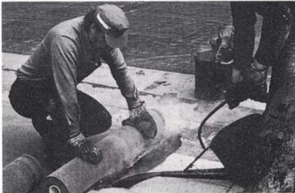
Kuva 1. Kermieristysten tekoa liimaamalla.
