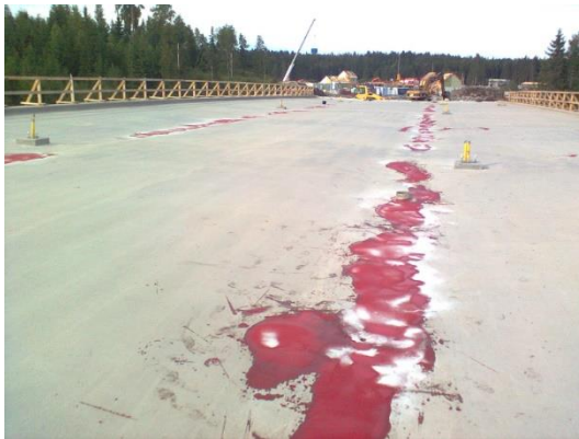
Tippuputkilijojen kallistukset korjattu.
