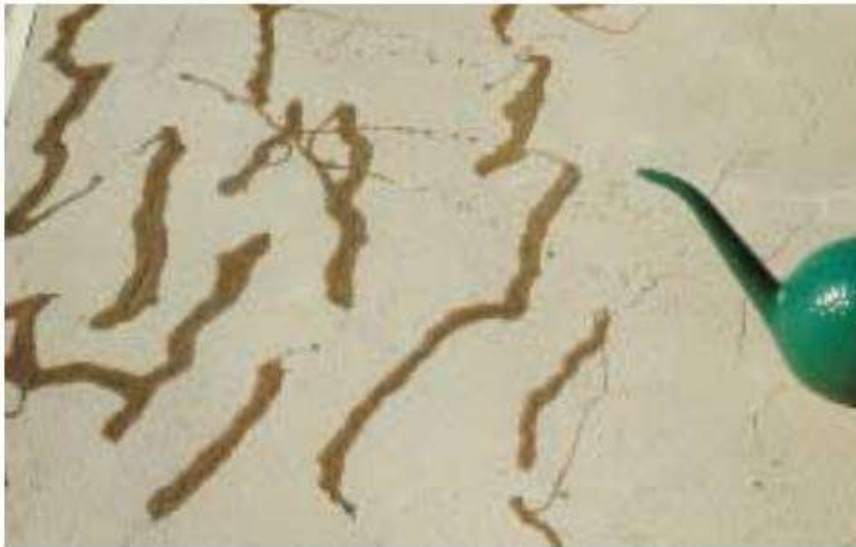
Kuva 4. Imeytysaine on kaadettu halkeaman päälle (vaihe 1).
