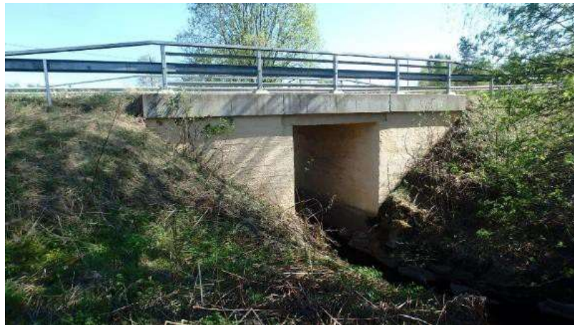
Orijärvenpuron silta, kannen pinta-ala 19 m 2 .
