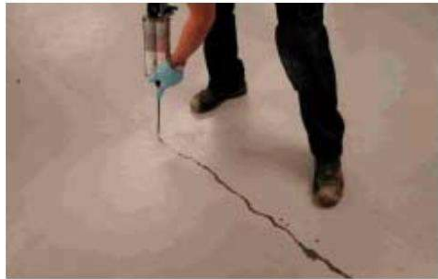
Kuva 8. Imeytys suuttimen avulla.
