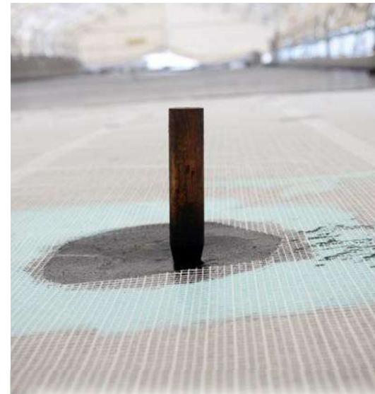
Tippuputken reikä tukittu.
