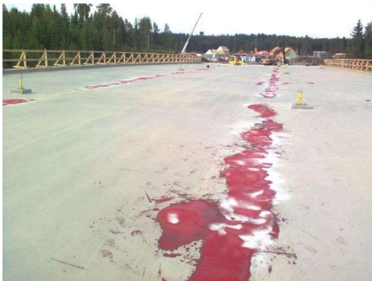
Tippuputkilijojen kallistukset korjattu.
