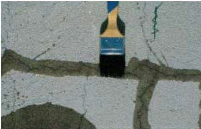
Kuva 5. Imeytysaine pidetään liikkeessä siveltimellä (vaihe 2).
