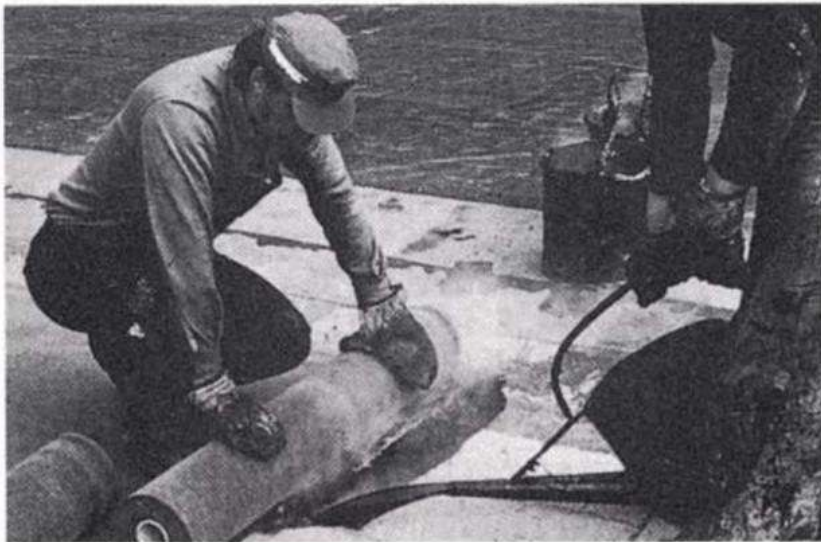
Kuva 1. Kermieristysten tekoa liimaamalla.
