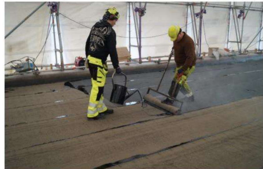
Kuva 1. Kermieristysten tekoa liimaamalla.
