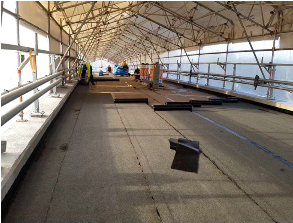
Hyvin asennetut ja limitetyt kermit.
