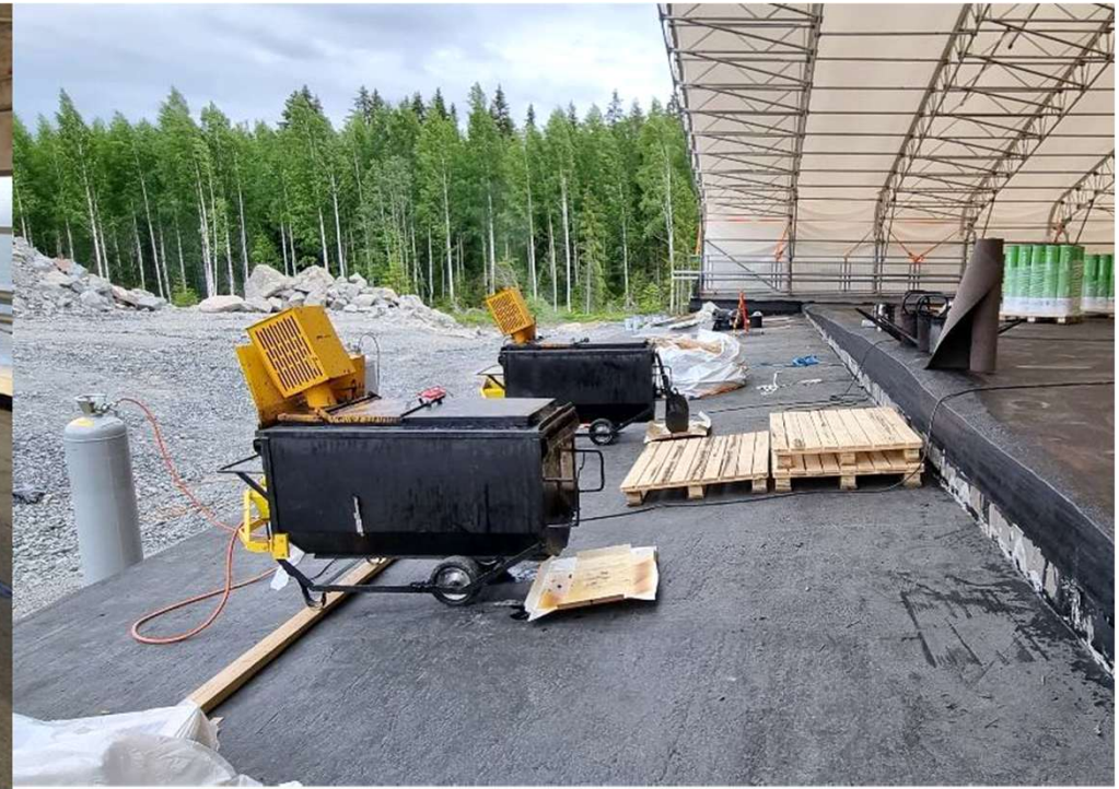
Bitumipata voi olla sääsuojan sisällä mutta tuuletus on varmistettava.
