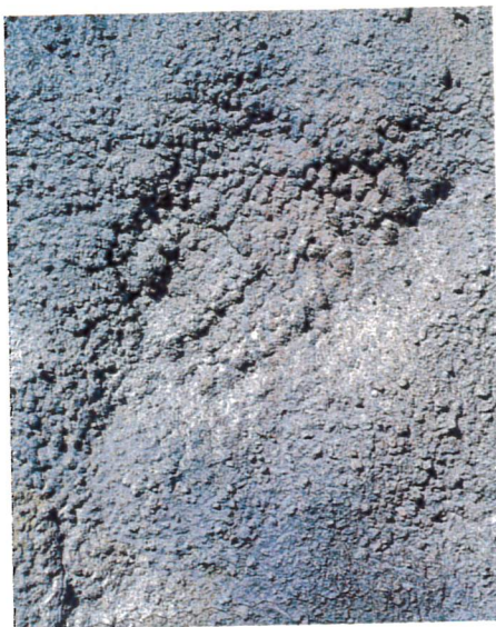
9. Korsun naamiointipintaa. Pinta on usein melko hyvin säilynyt, vaikka sille ei asetettu erityisiä teknisiä vaatimuksia. Korsut eristettiin bitumisivellyllä, jonka päälle rapattiin käsin noin 5 cm paksu naamiointikerros, jossa käytettiin erilaisia värejä. Naamiointikerroksen betoniteknikkaan ei kiinnitetty erityistä huomiota ja se on monessa korsussa rapautunut.
