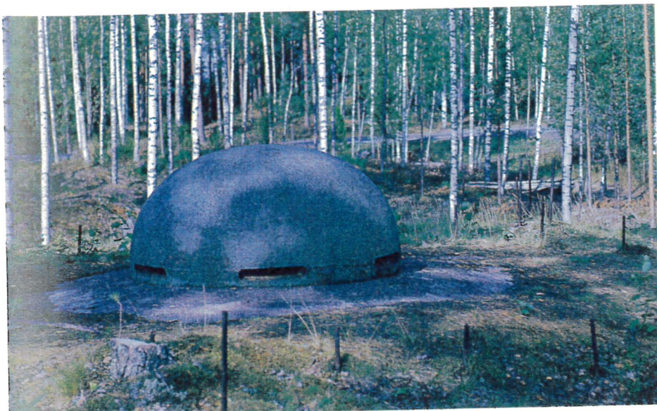
11. Tähystyskupu kuuluu lähes jokaiseen korsuun. Kupu on valurautaa ja painaa 10 tonnia. Valurauta on suhteellisen hyvin korroosiota kestävä ja myös kuvut ovat hyvässä kunnossa.
