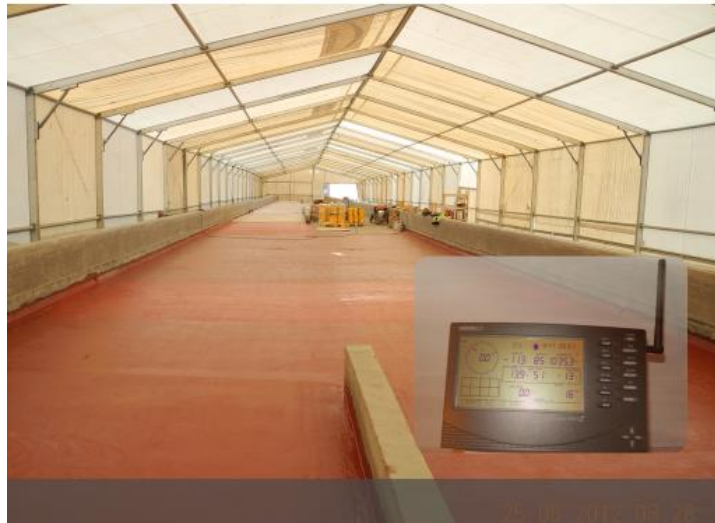
Sillan vedeneristystömaan laadunmittaus 2017
