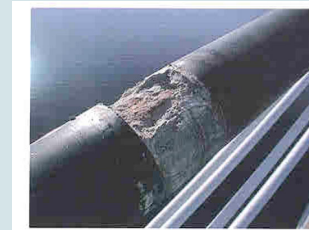
Kuva 17 Lisäankkurointikaapelien suojaputki
